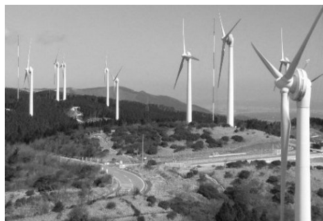
写真8 風力発電設備(750kW, 2000kWの2機種)
